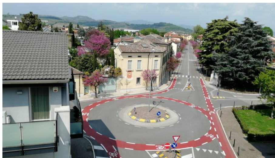
Radweg mit Kreisverkehr in San Bonifacio, Verona
