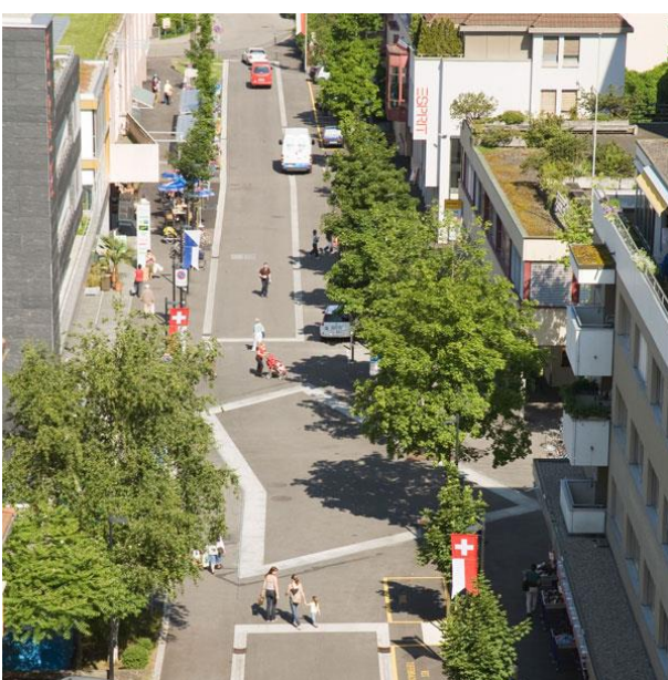
Begegnungszone (20) in Uster, CH
